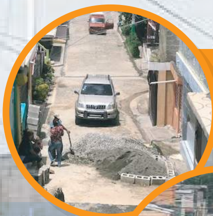
Asfaltado Calle Los Altos 3ro
