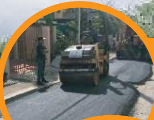
Asfaltado y Bacheo El Milloncito 1ro
