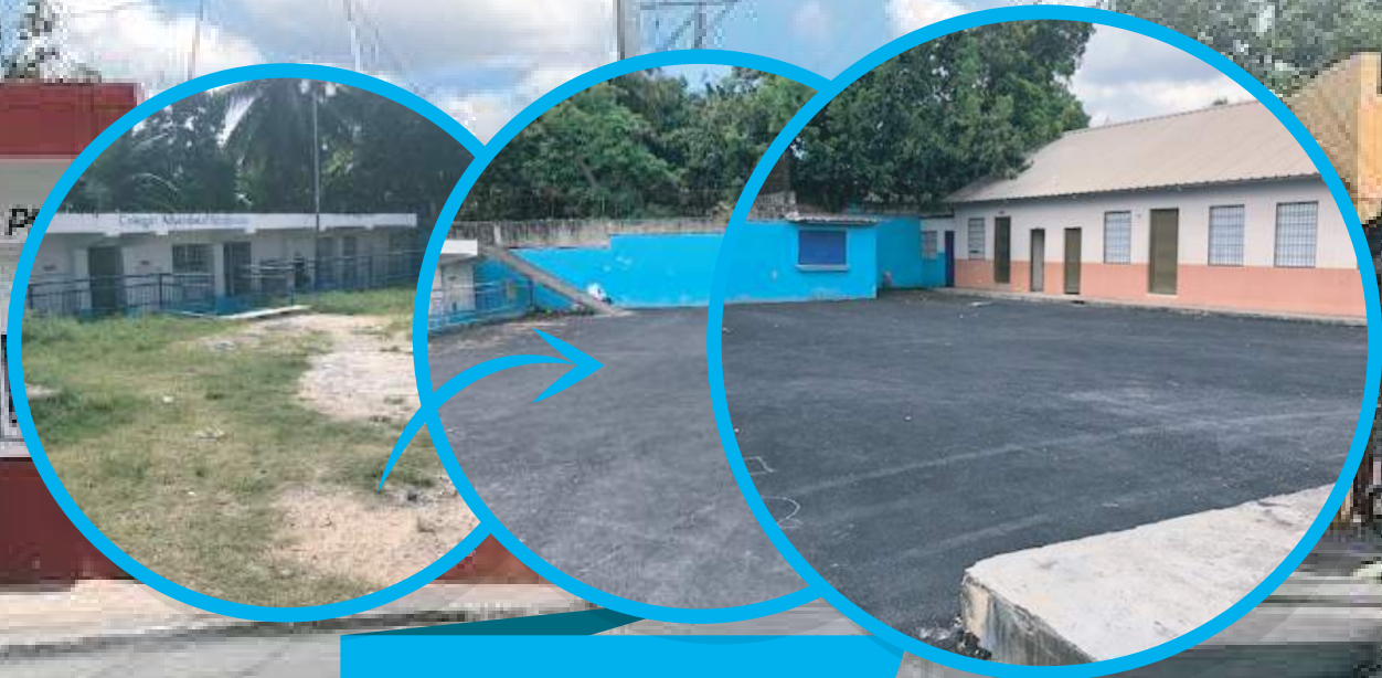
Bacheos Técnico y Asfaltado Parqueo Iglesia Adventista
